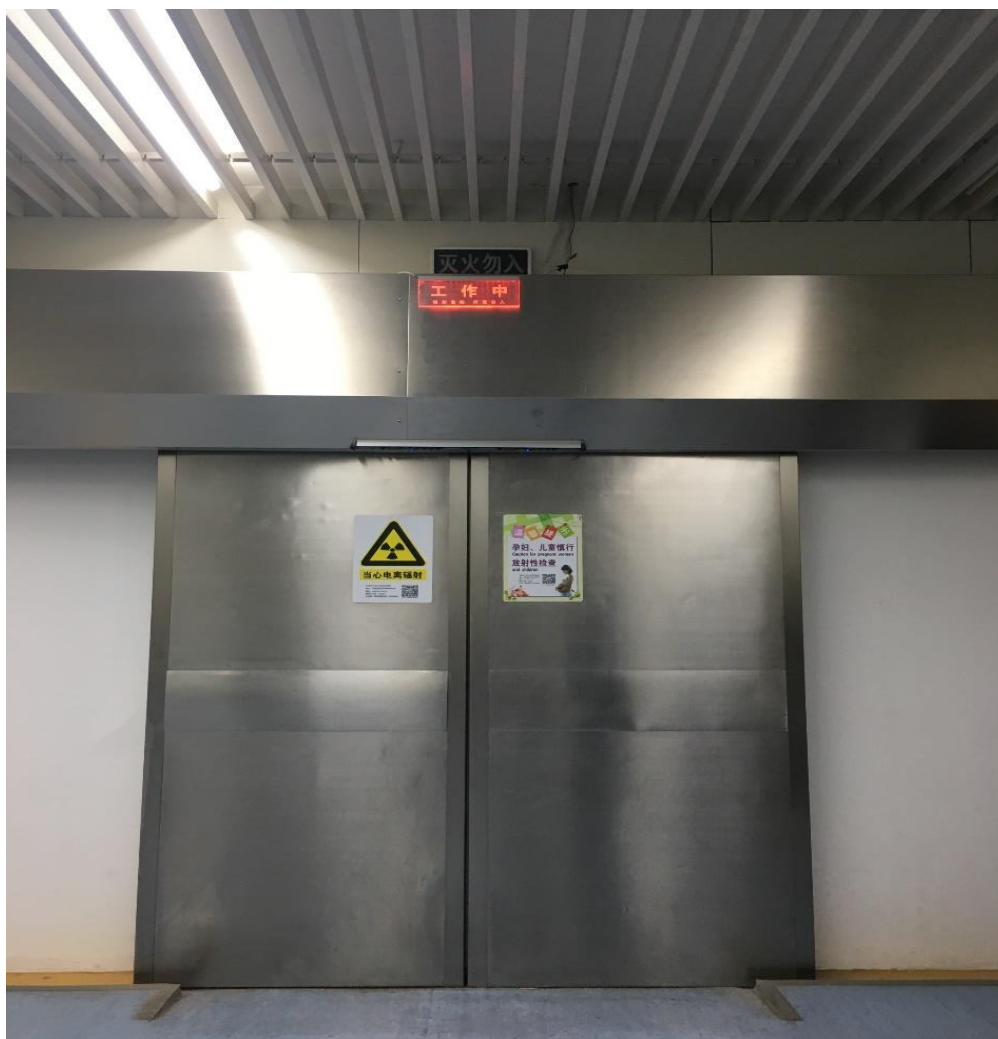
附图 6 防护门工作中状态联动系统
